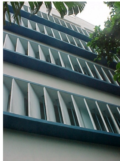
Figs.03 e 04: Fachada principal e detalhe dos brises da fachada oeste Fonte: Espaço Saúde, 2002detalhe dos brises da fachada oeste
