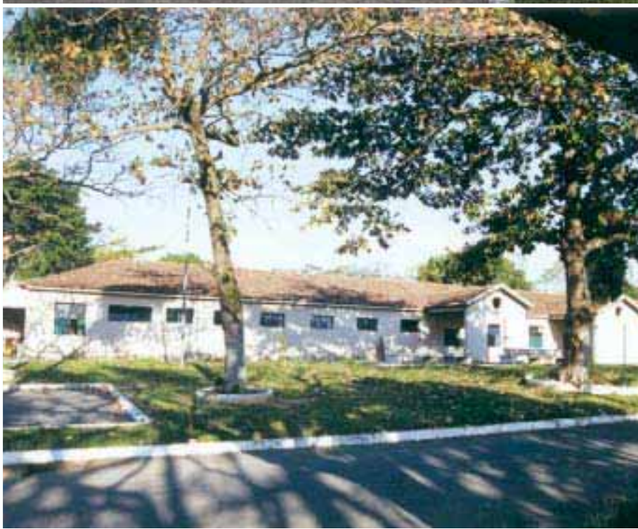
27 - NTB - Pavilhão localizado nos fundos da sede administrativa (2ª e 3ª Seções de enfermarias).
