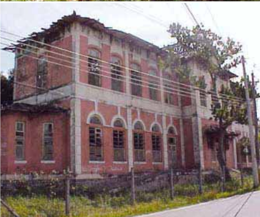
71 - NRC - Pavilhão 1 (desativado). Futura sede do Museu Bispo do Rosário.
