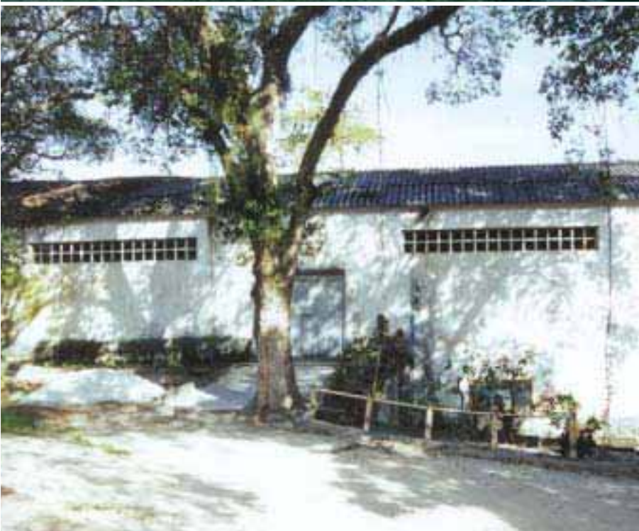
35 - NFR - Galpão de trabalho (terapias).
