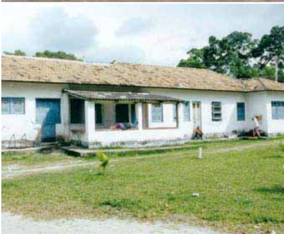
38 - NUV - Pavilhão 1 – sede administrativa (fundos).
