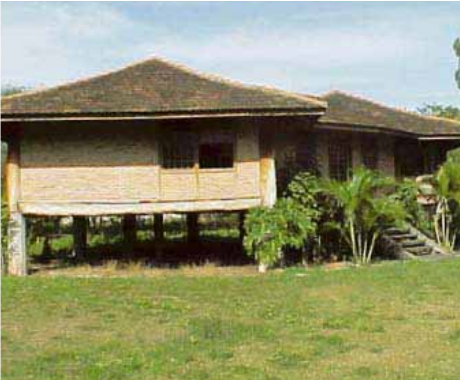
4 - Horto (IEF) - Sede administrativa - Projeto do arquiteto José Zanine Caldas.
