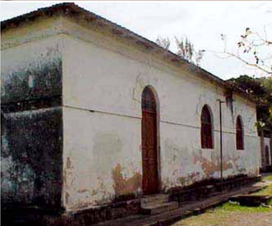
65 - NRC - Lavanderia, localizada em uma das extremidades do Pavilhão Carolina Medrado.
