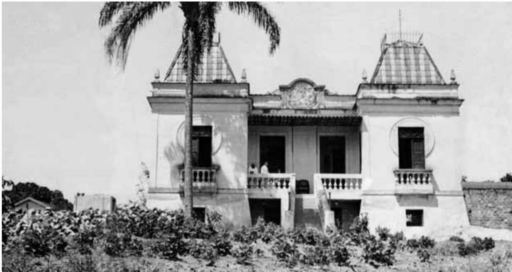
Edificação primitiva do asilo de incuráveis da Penha
