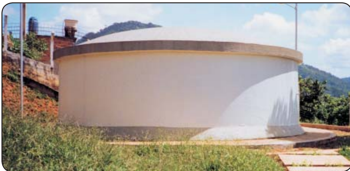
Foto 5 — Reservatório em concreto armado apoiado
