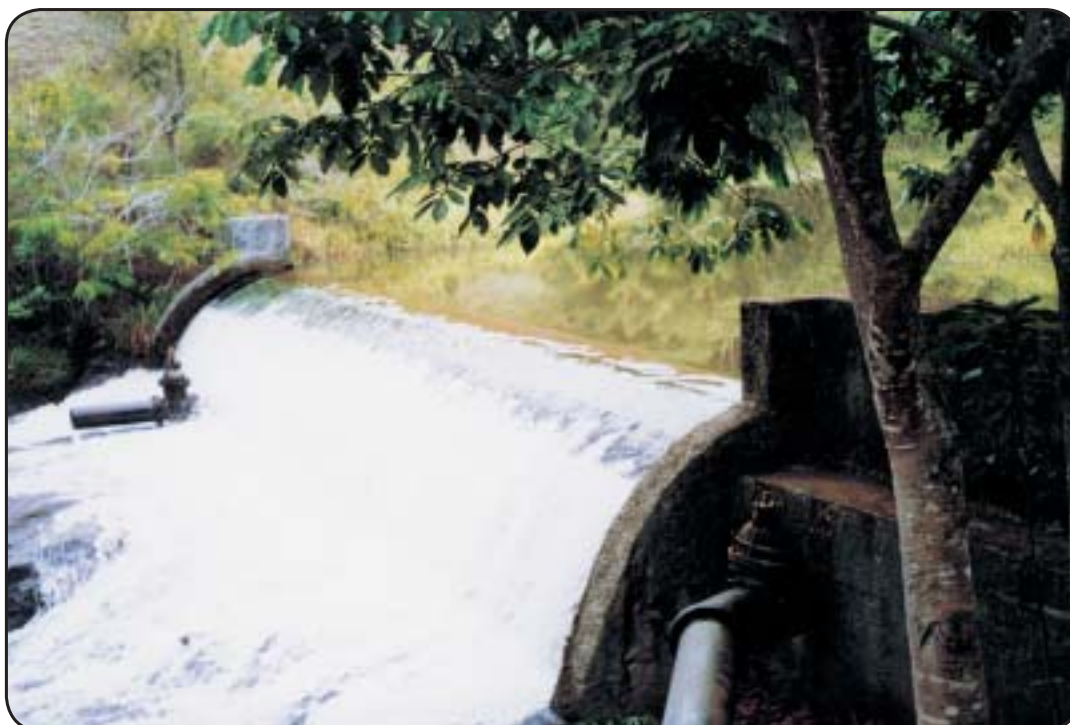
Foto 1 - Tomada direta com barragem de nível
