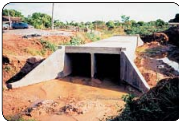
Foto 30 — Galeria de Concreto Armado
