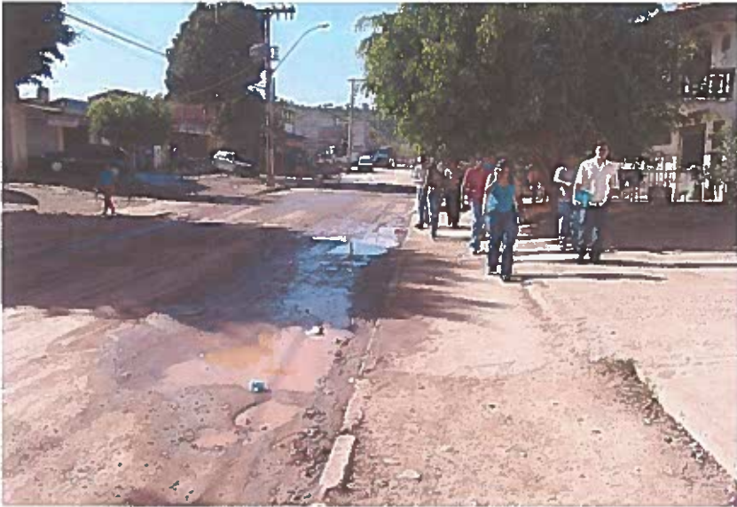
Figura 5.12. Água e sedimentos acumulados na via pública.
