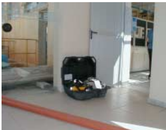
Fig. 9 - Conjunto respiratório autônomo próximo ao local de adição de cloro à água
