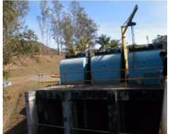
Fig. 2 - Equipamento para içar resíduos
