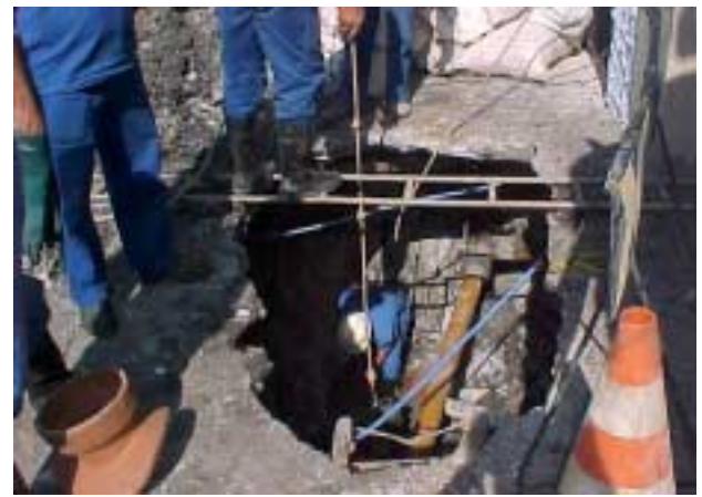
Fig. 21 e 22 - DIMENSÕES DA VALA (+/-) : 4,5m x 2,5 m ; profundidade 2,8 / 3m Condições de segurança totalmente impróprias , inadequadas e perigosas, devido a: 1) inexistência de qualquer tipo de escoramento no interior da vala; 2) trabalhador mantém contato corporal direto com esgoto; 3) cargas sobre a parte superior da vala: entulhos e trabalhadores; 4) trabalhadores em posicionamento inseguro sobre a vala; 5) escada de mão em posição distante do trabalhador
