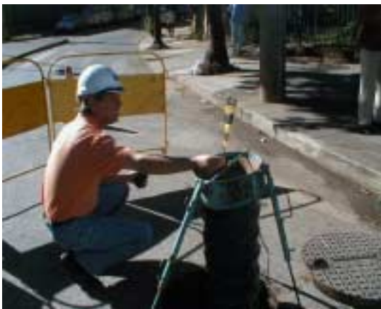
Fig. 15 - Uso simultâneo de insuflador de ar e a fase de aspiração do ar insuflado
