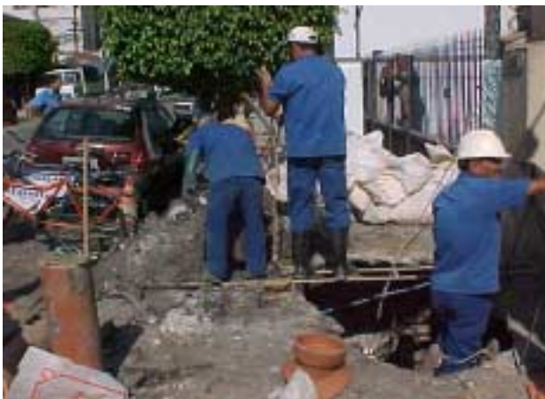
Fig. 21 e 22 - DIMENSÕES DA VALA (+/-) : 4,5m x 2,5 m ; profundidade 2,8 / 3m Condições de segurança totalmente impróprias , inadequadas e perigosas, devido a: 1) inexistência de qualquer tipo de escoramento no interior da vala; 2) trabalhador mantém contato corporal direto com esgoto; 3) cargas sobre a parte superior da vala: entulhos e trabalhadores; 4) trabalhadores em posicionamento inseguro sobre a vala; 5) escada de mão em posição distante do trabalhador
