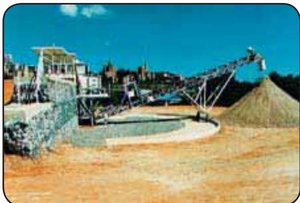
Foto 19 — Usina de reciclagem de entulhos
