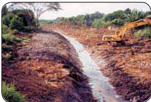
Foto 29 — Retificação de Canal Natural
