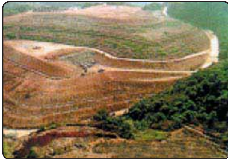
Foto 28 – vista aérea de um aterro sanitário
