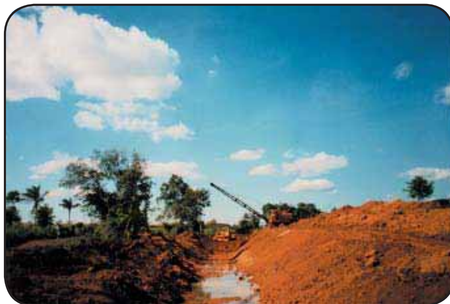
Foto 31 — Dragagem com drag-line
