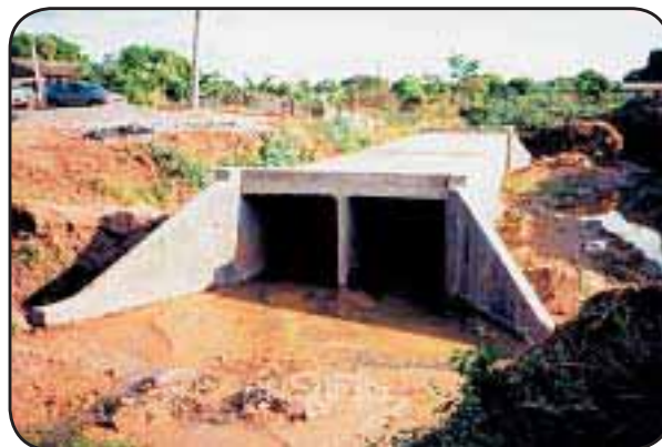
Foto 30 — Galeria de Concreto Armado
