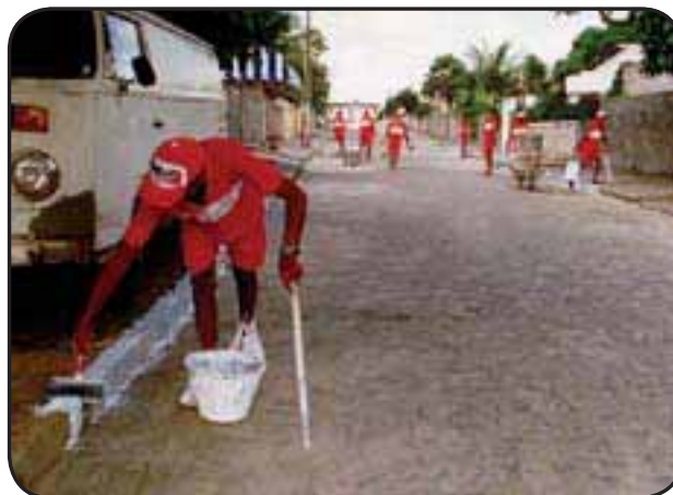
Foto 18 — Pintura de meio-fio
