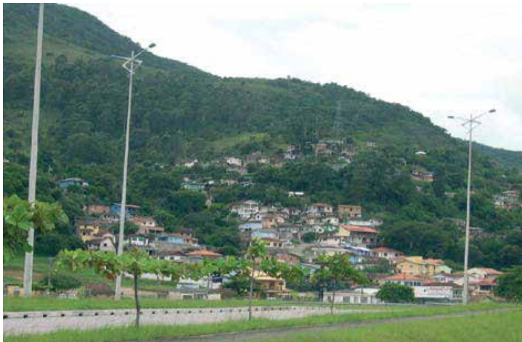
Figura 18 – Ocupação de encosta da Serra do Mar
