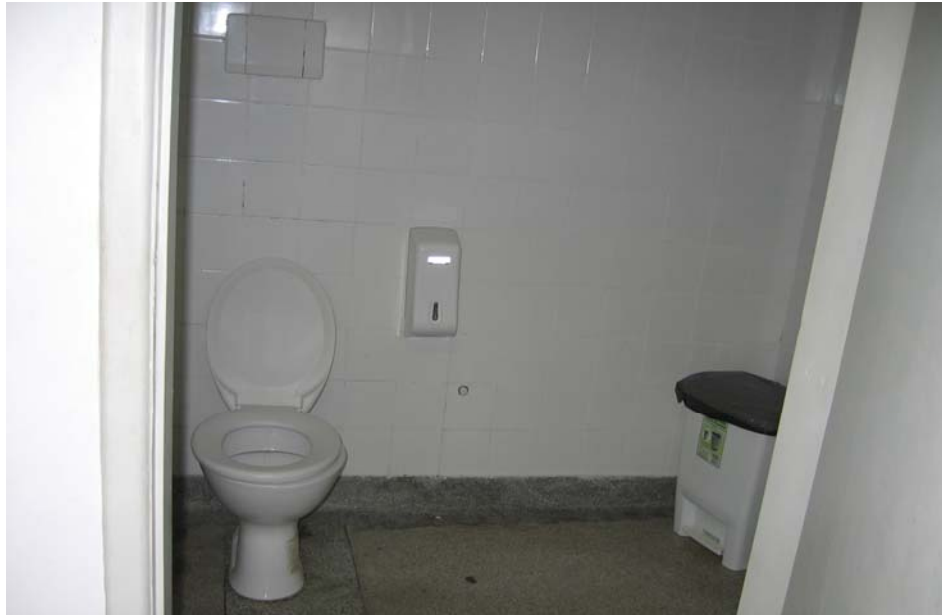
Foto 12. Sanitários com área de transferência suficiente. Fonte: A autora em 17 de outubro de 2007
