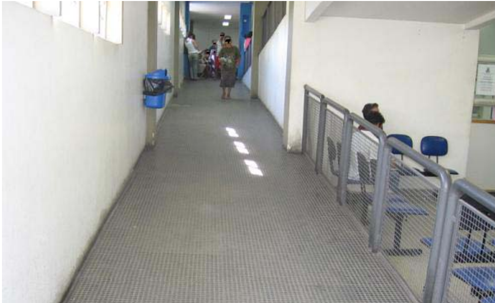
Foto 7. Guarda corpo das rampas. Fonte: A autora em 17 de outubro de 2007
