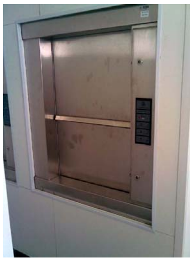
Foto 4: Vista externa de monta-carga
