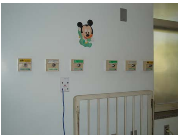
Figura 12: Tubulações embutidas no hospital público
