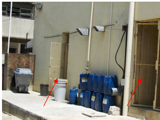
Entrada e saída descoberta de roupas na unidade de processamento.
