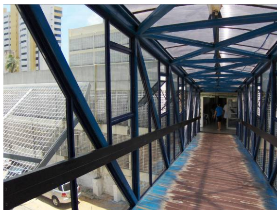
Passarela de ligação entre o PSCS e o HMWG.
