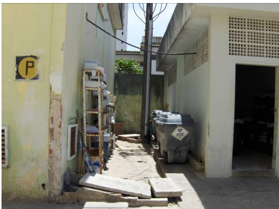
Equipamentos e mobiliário armazenados em área descoberta.
