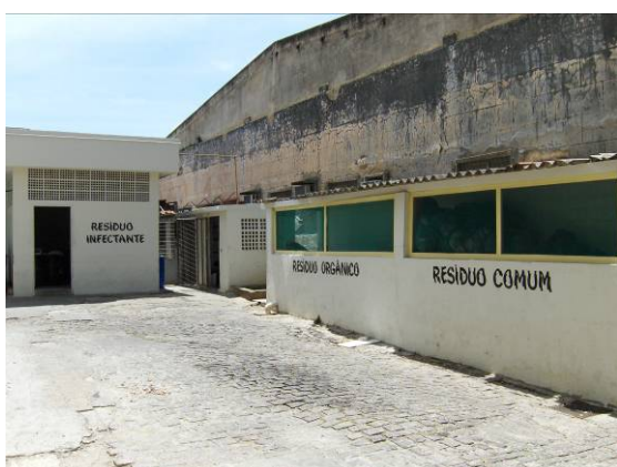
Abrigo de resíduos.
