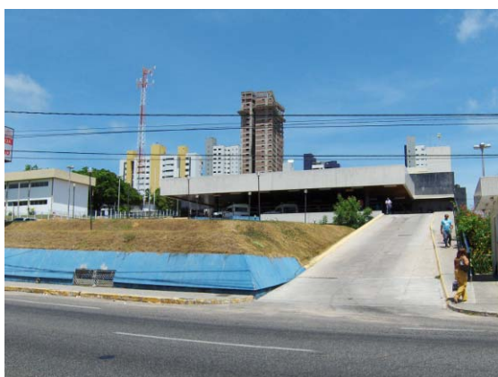
Figura 14: Fachada Frontal do complexo. Fonte: Autora, 2008
