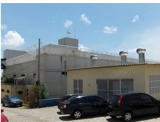
Subestação localizada próximo ao PSCS.
