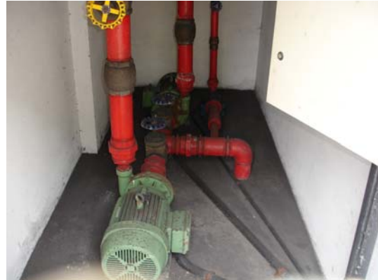
Fotos 9 e 10 – Hospital 1 – Uso de cores nas tubulações Fonte: Palhares, 2007.
