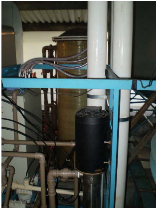
Fotos 1 e 2 – Hospital 1- Área de tratamento de água para diálise – filtros e reservatório Fonte: A Autora, 2007.
