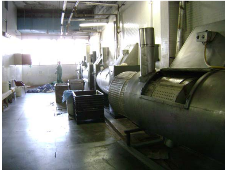
Foto 20 – Hospital 3 – Processamento de Roupas – Área Suja Fonte: Autora, 2007.
