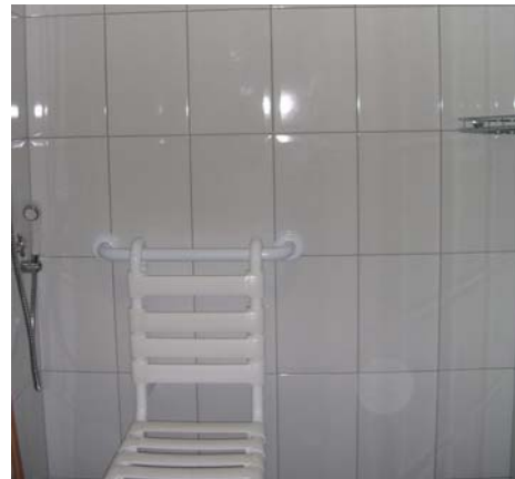
Foto 13 – Hospital 2 -Detalhe Box Banheiro Suíte Fonte: Autora, 2007.
