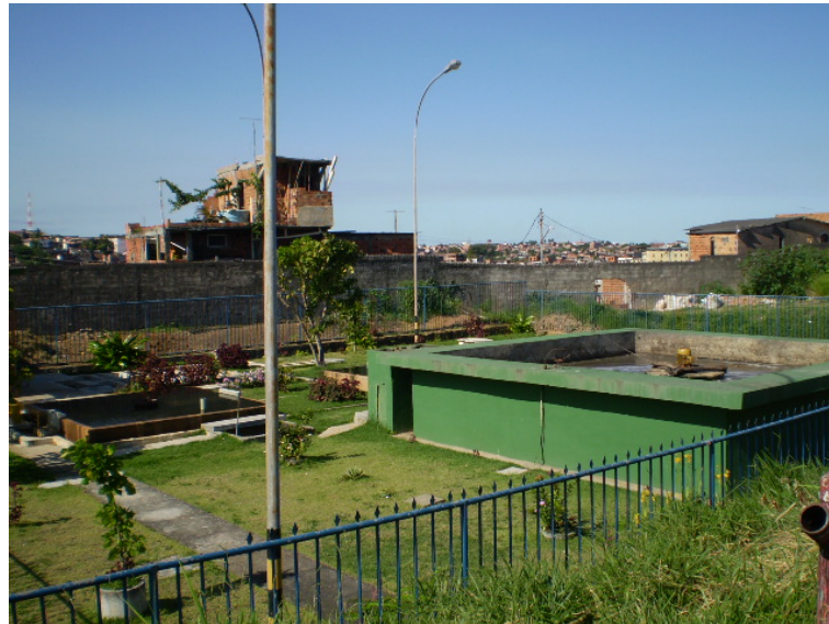
Foto 24 – Hospital 3 – ETE vista geral Fonte: Autora, 2007.
