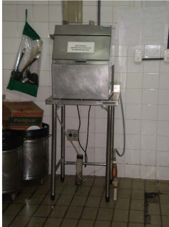
Foto 30 – Hospital 4 – Máquina de gelo Fonte: Autora, 2007.
