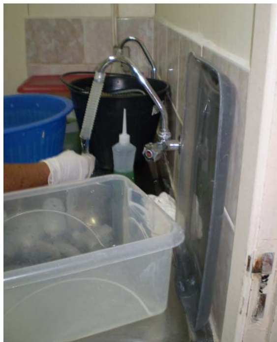
Foto 29 – Hospital 4 – Vestiário Lavagem Fonte: Autora, 2007.
