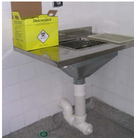
Fotos 15 – Hospital 2 – Expurgo – Pia de despejo Fonte: Autora, 2007.
