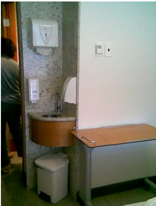
Foto 14 – Hospital 2 – Quarto - Lavatório Fonte: Autora, 2007.
