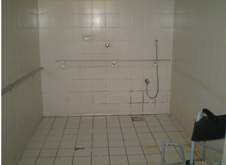
Fotos 22 – Hospital 3 – Sala de Higienização Fonte: Autora, 2007.
