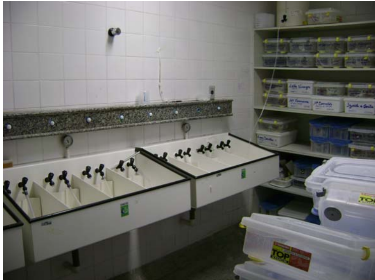
Foto 4 – Hospital 1- Sala de reprocessamento de dialisadores. Fonte: A Autora, 2007.
