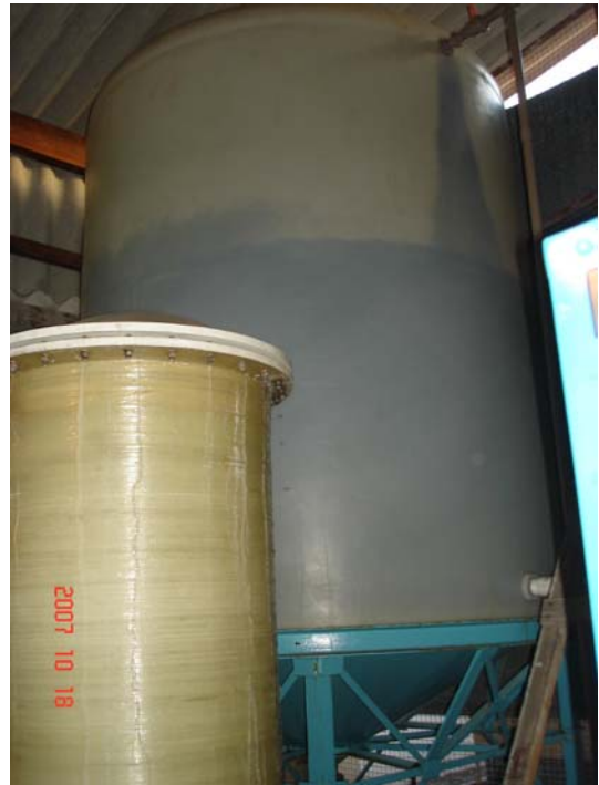
Fotos 1 e 2 – Hospital 1- Área de tratamento de água para diálise – filtros e reservatório Fonte: A Autora, 2007.
