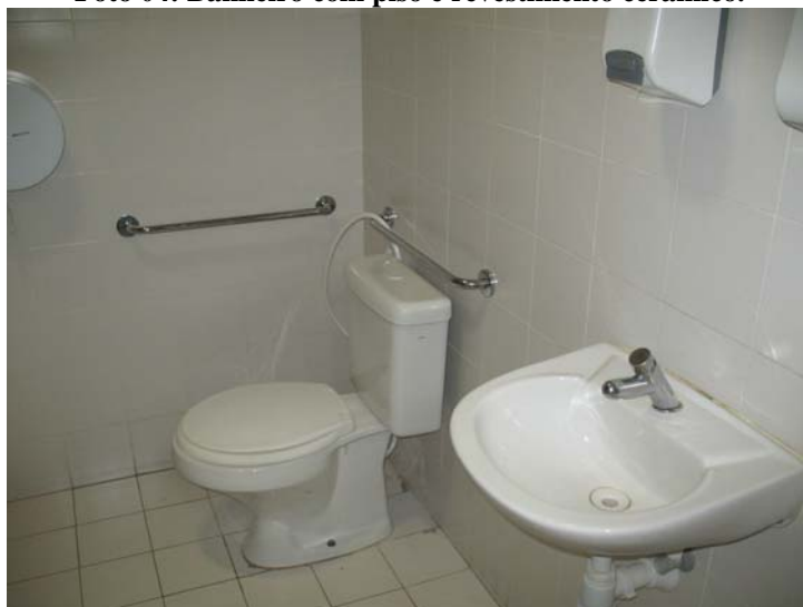
Foto 04: Banheiro com piso e revestimento cerâmico.
