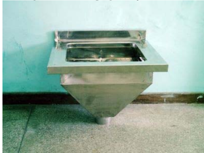
Figura 04: Pia de expurgo em aço inoxidável.
