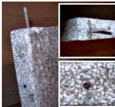
Figura 02: Detalhes do pisos
