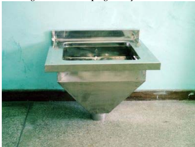
Figura 04: Pia de expurgo em aço inoxidável.
