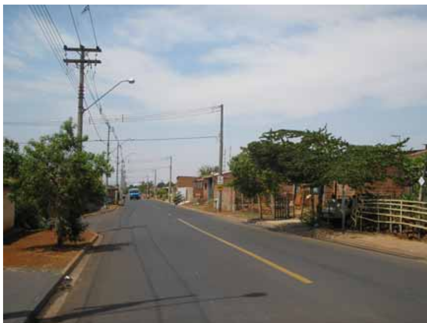
A rua entre a favela e o bairro de casas COHAB
