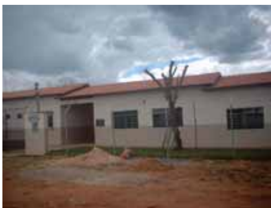
Figura 7 – Nova escola de Chapadinha, Unaí-MG.
