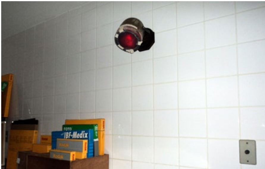
Figura 83. Canhão da luz de segurança da câmara escura Fonte: Acervo SQRI.
