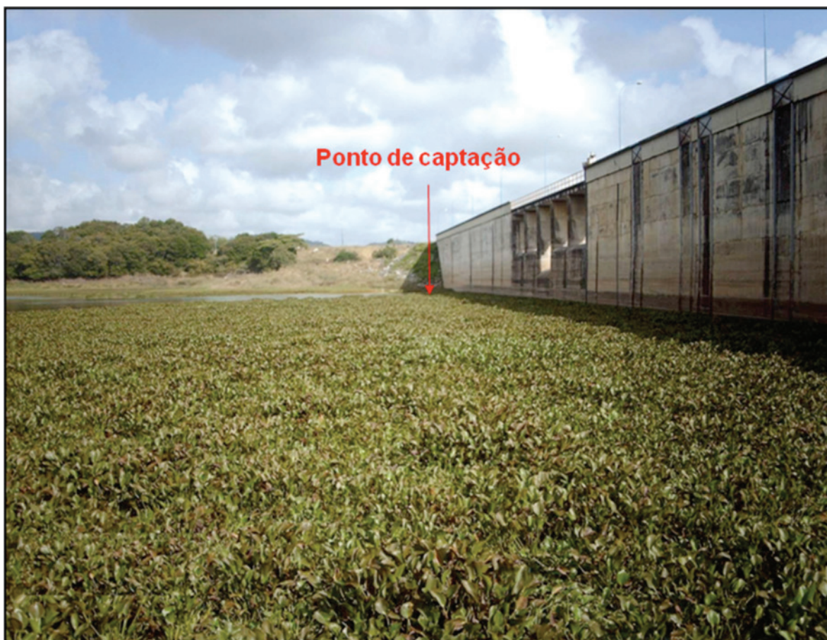
Figura 10 – Paredão do reservatório de Tapacurá-PE, com indicação do ponto de captação
