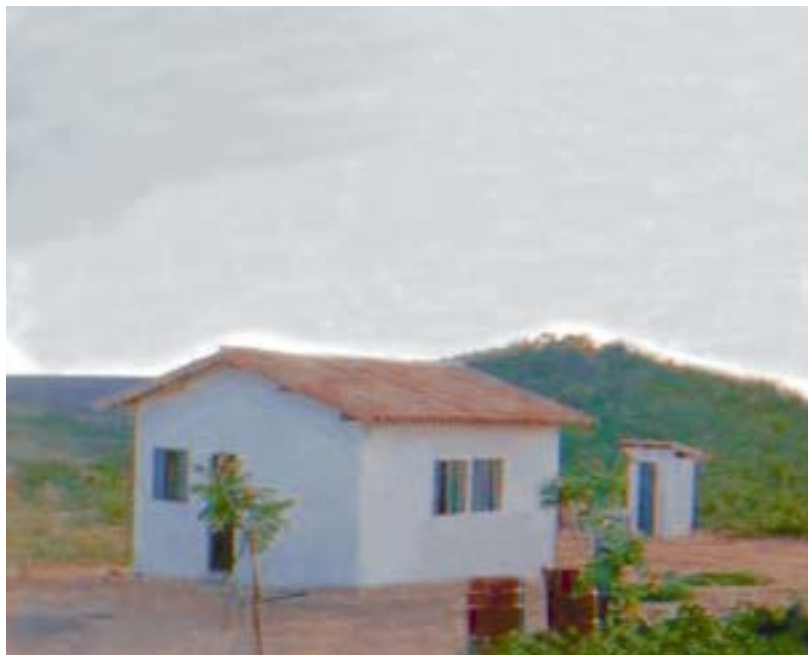
Figura 4. Casa depois da reconstrução
