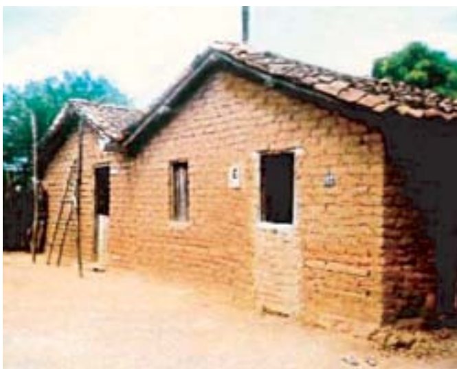
Figura 1. Casa antes da restauração
