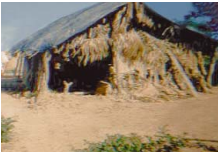
Figura 3. Casa antes da reconstrução
