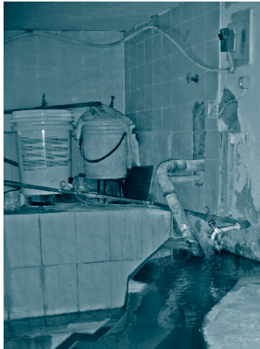
Figura 5.3 – Exemplo de identificação de perigo: instalações e controle precários da mistura rápida e coagulação
