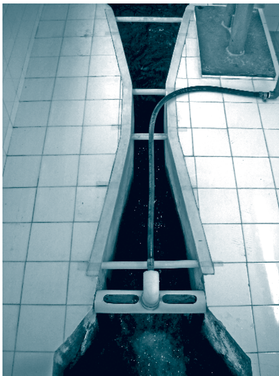
Figura 3.13 – Calha Parshall para medição de vazão e mistura rápida
