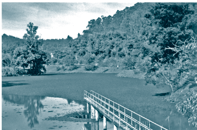
Figura 3.4 – Torre de tomada de água
