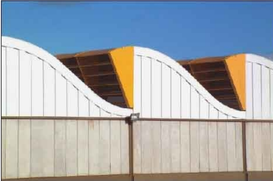
Fig. 2 - Vista externa do CTRS, em Salvador, BA, onde se utilizou o sistema construtivo desenvolvido para a execução dos hospitais da Rede SARAH. Observa-se o uso da modulação no emprego da argamassa armada (nos painéis das vedações) e do metal (na estrutura e nos elementos da cobertura).
