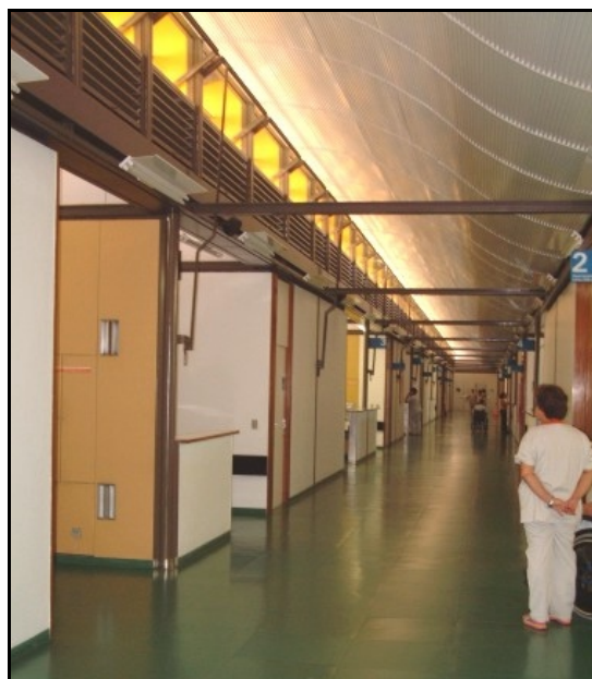
fig. 3 - Foto de trecho do corredor central do Hospital SARAH Salvador. Observa-se a harmonia na modulação dos diversos elementos do sistema construtivo, o qual permite, de maneira racional, a adoção de soluções arquitetônicas variadas, bem como eventuais modificações
