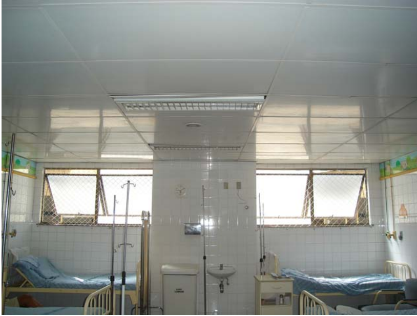
Figura 11: Vista da iluminação artificial centralizada na enfermaria Fonte: A autora
