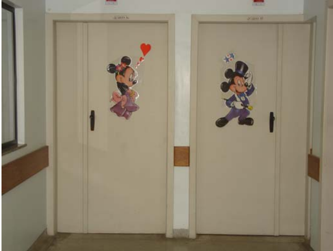
Figura 06: Vista das portas do hospital público
