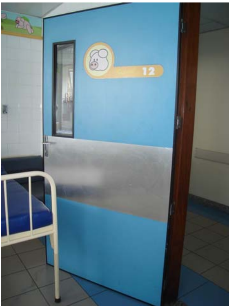
Figura 07: Vista da porta do hospital filantrópico
