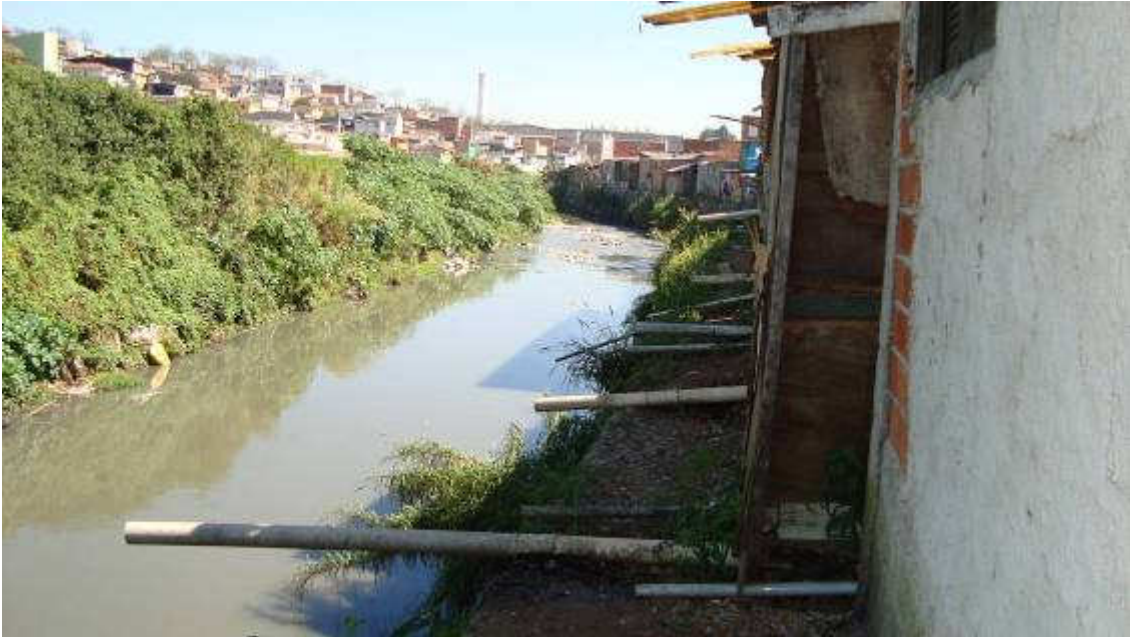
Foto 4. Esgoto encanado deságua no rio Oratório sem tratamento. 2009. Fonte: Trabalho de campo.
