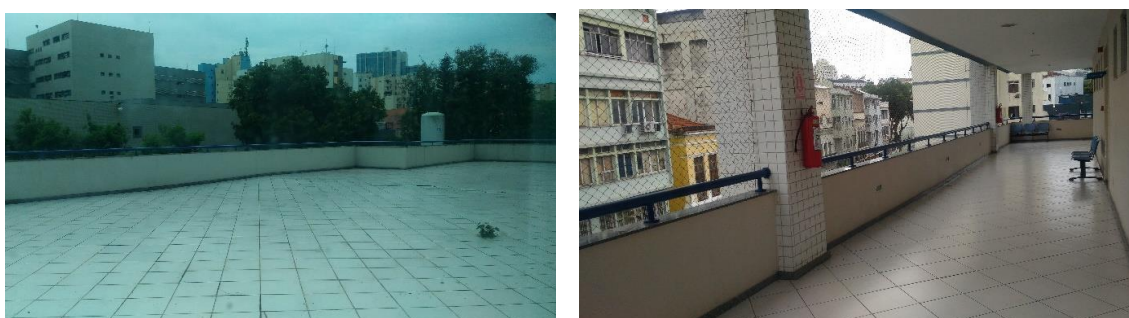
Figura 66– Terraço descoberto e varanda lateral – 3º pav. – HMMABH
