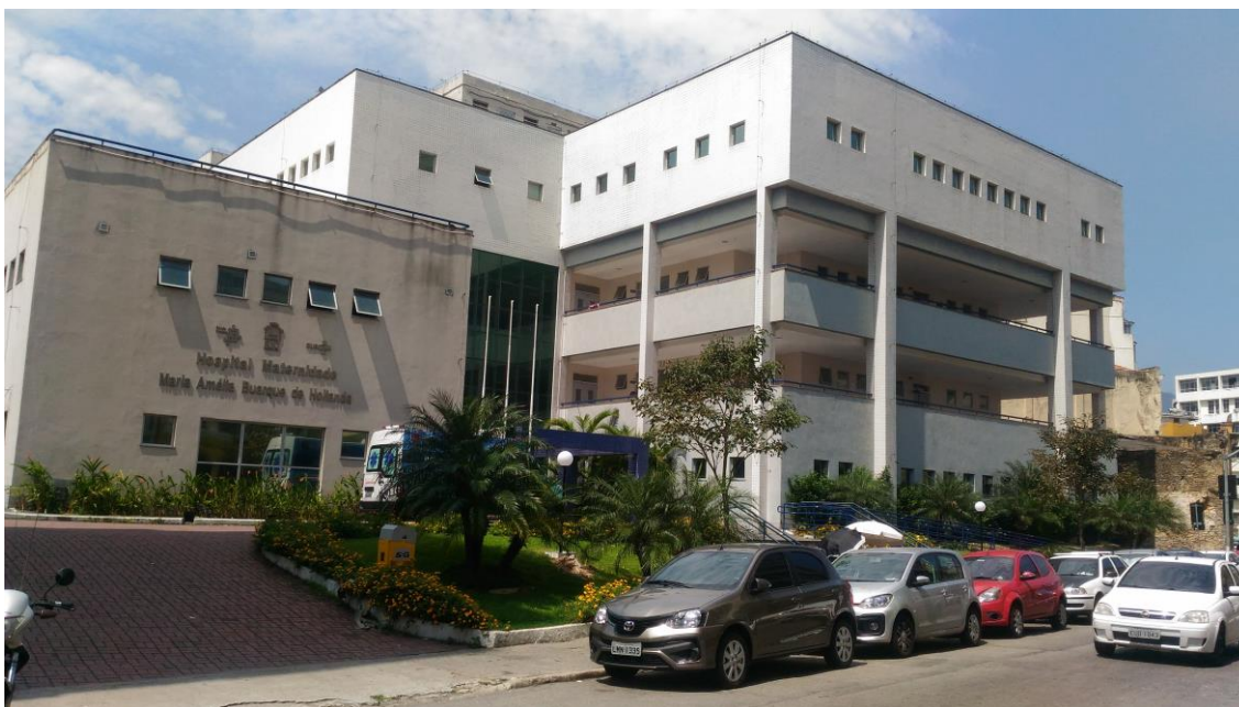
Figura 49 – Fachada principal do Hospital Maternidade Maria Amélia B. de Hollanda
