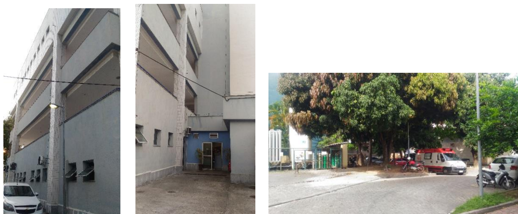
Figura 63 – Fachada de fundos, acesso de serviço e pátio compartilhado com o HMSA
